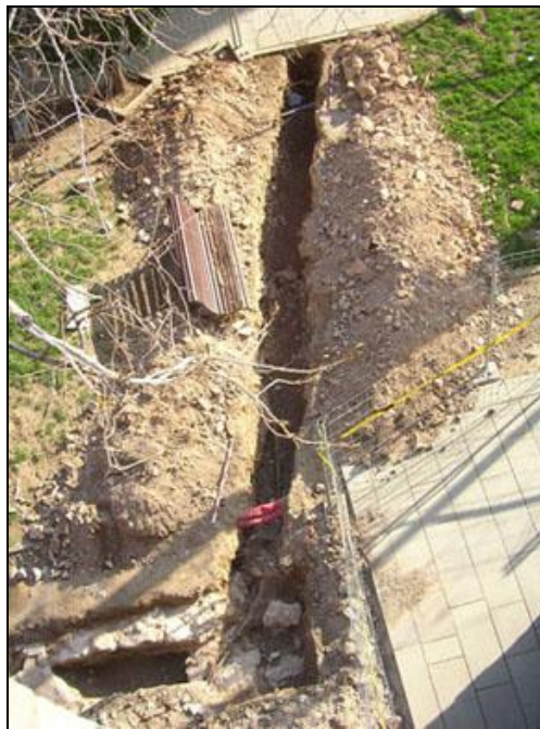
375-017-07. Rasa 600, una vegada acabada
