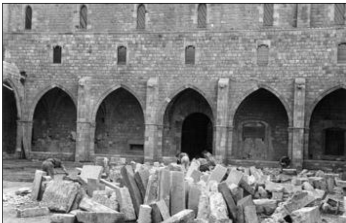
Vista de la nau septentrional amb la galeria superior coberta. Es pot veure en la part esquerra el darrer arc de la nau de ponent sense restaurar. (Fotografia AHBC);
