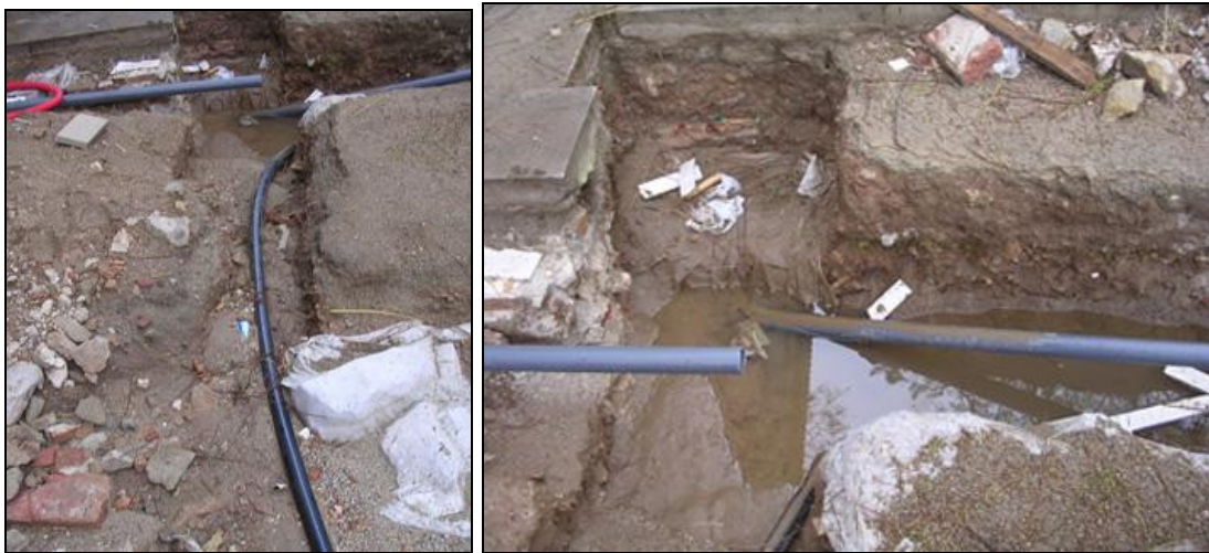
450-017-07 i 451-017 -07. Rasa 800 amb les estructures afectades per la pluja.
