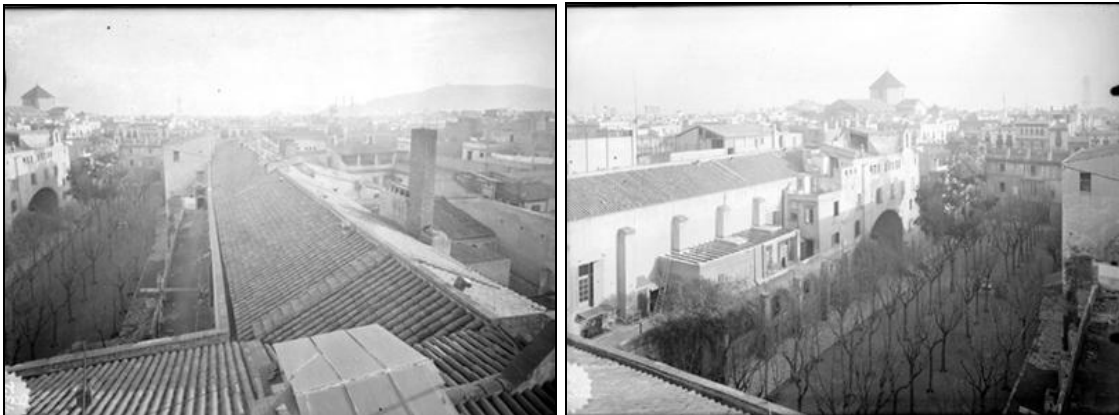
Vistes del pati de l'Hospital abans de començar-s'hi les obres de rehabilitació. (fotografia de MHBC.)
