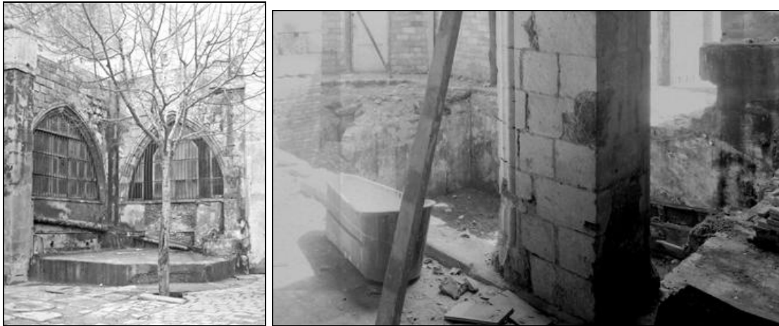
Detall del dipòsit situat al NW del pati claustral, abans i després de que es desmunti la seva coberta. (fotos cedides pel AHBC).
