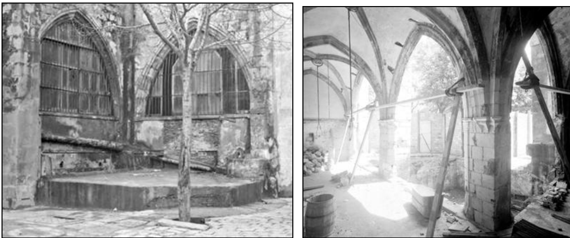
Vistes del dipòsit ubicat all NW del pati, amb coberta i durant la rehabilitació de la nau. (fotos AHBC).
