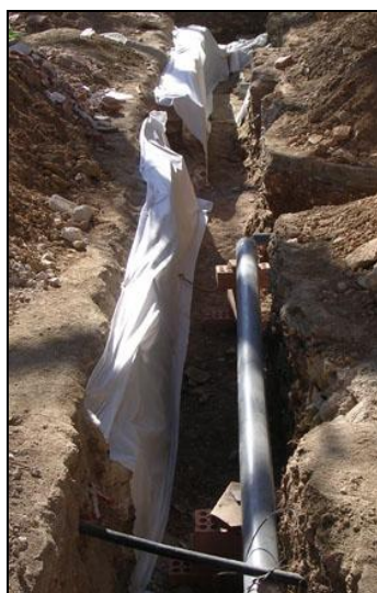
250-017-07 i 314-017-07. Fonamentació UE 514 i UF 21, 22 i 23 cobertes amb geotèxtil.
