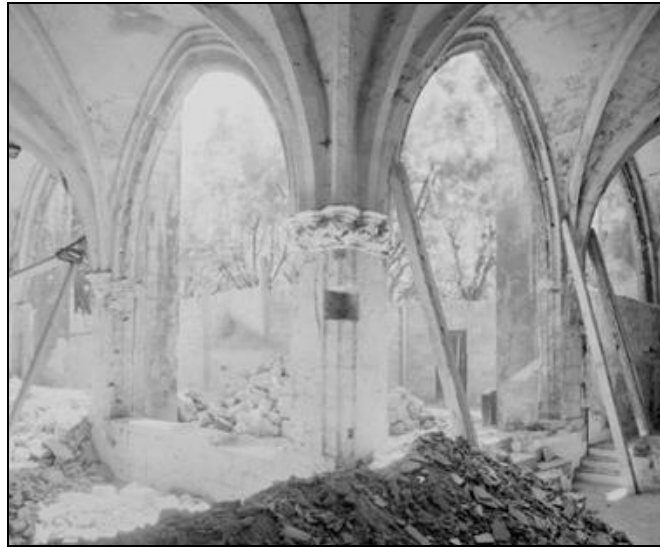
Detall de l'estat en que es troba la primera arcada de l'ala de llevant en el moment en que es fan les primeres obres de neteja als anys trenta. (Foto AHBC).
