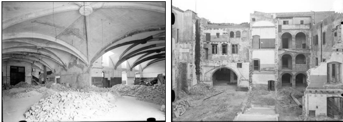
Tasques de neteja de les naus gòtiques, i d'enderrocs a la zona del carrer Egipcíacues. Fotos AHBC.
