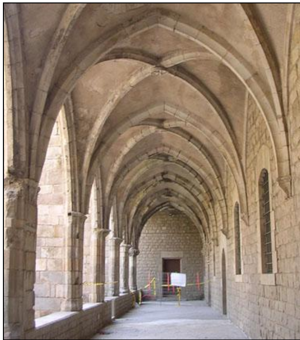
1 era : Interior del laboratori farmacèutic ubicat als darrers trams del claustre de la nau de ponent, als darrers temps de l'hospital (Fotografia del AHBC); 2 a : 498-017-07. Estat actual d'aquest tram del pòrtic.
