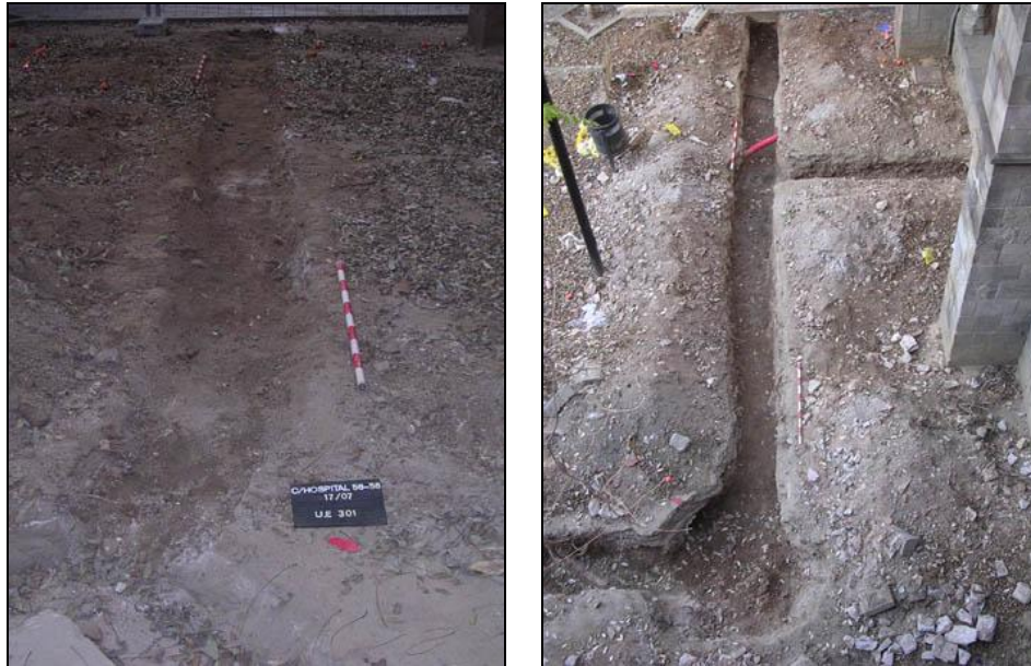
151 i 152-017-07. Foto inicial i final de la rasa 300 (encara sense fer la rasa 3200)
