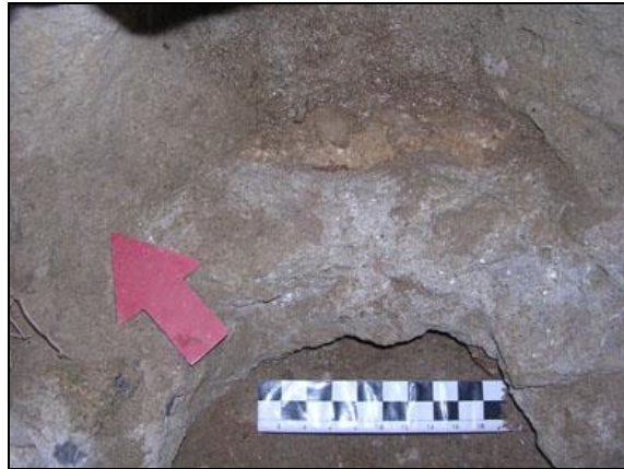
133-017-07. Detall del morter (color groguenc) del mur original, UE 1609, del claustre segle XV.
