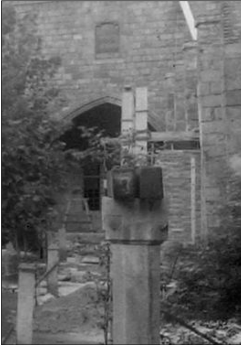
Detall de les obres realitzades a la nau de llevant. (foto AHBC)
