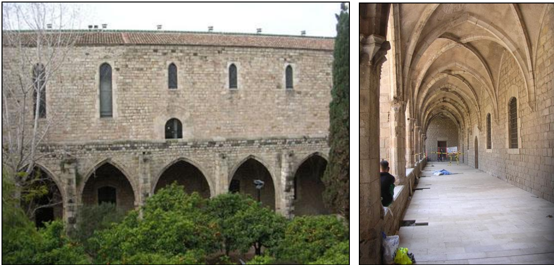
493-017-07 i 498-017-07. Detall de la façana de la nau de ponent i de l'interior de la seva ala del claustre.
