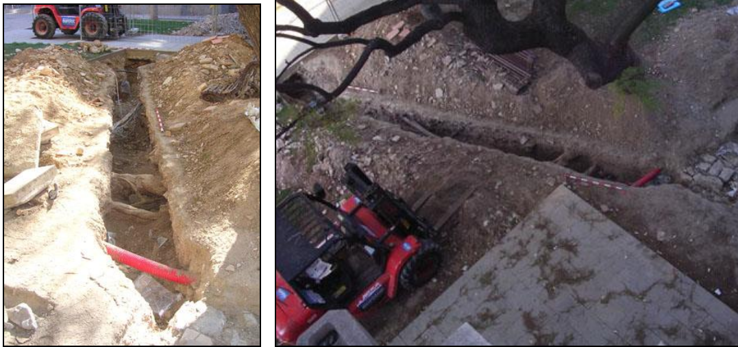
139-017-07 i 138-017-07. Detall de la rasa 200 una vegada finalitzada.
