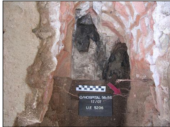
329-017-07. Part superior del mur UE 5206 que sustenta la coberta UE 5204.
